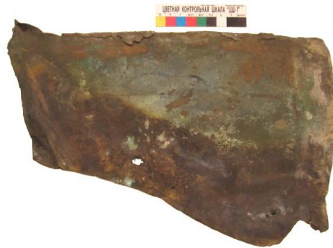
Рис. 2. Фрагмент выколотной медной скульптуры с центральной башни здания Главного Адмиралтейства
